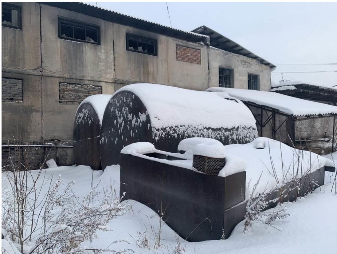
Фото В.1 – общий вид
